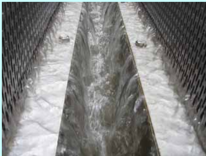
effluent trough
