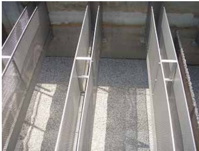
effluent trough
